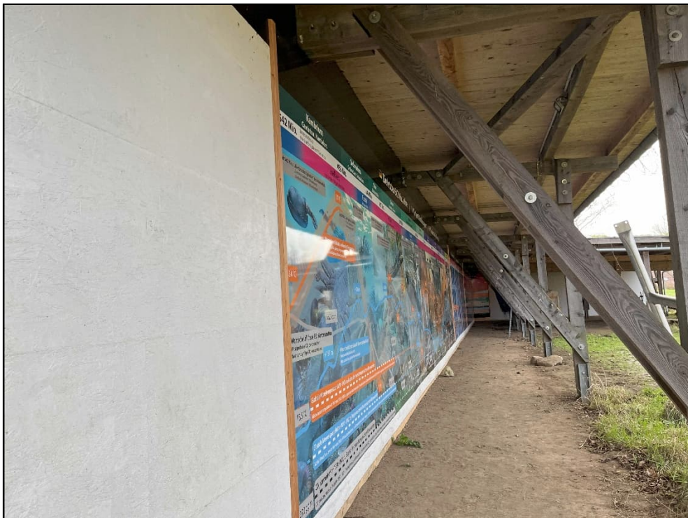
Abb. 3.2: Lärmschutzanlage Süd, Ansicht 2 von Ost
