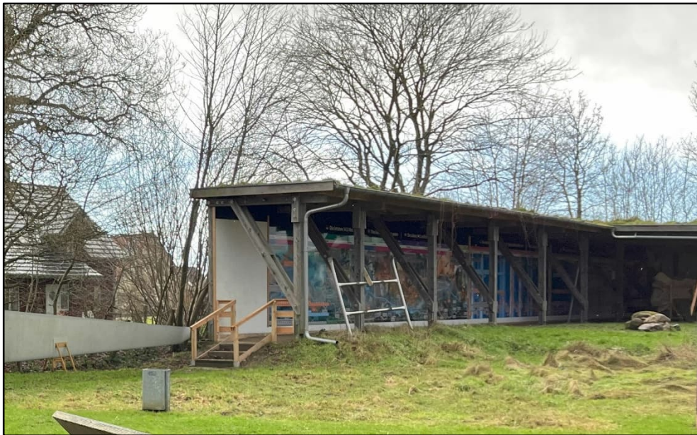
Abb. 3.1: Lärmschutzanlage Süd, Ansicht 1 von Nordost
