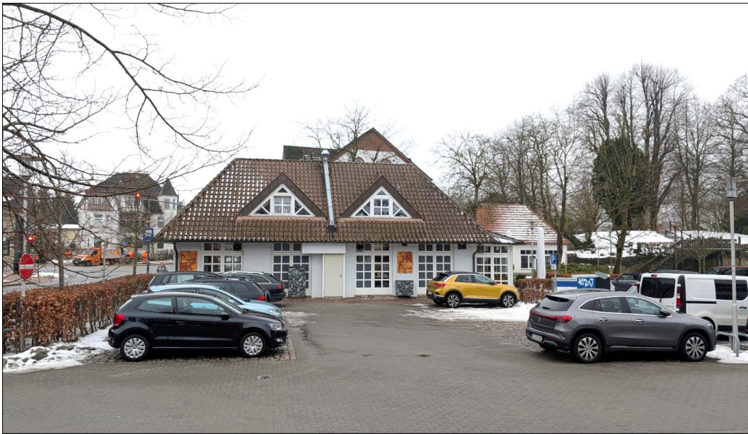
Abbildung 1: Blick auf die Nordost-Seite des Bestandsgebäudes, an die der Anbau geplant ist (Quelle: eigene Darstellung)
